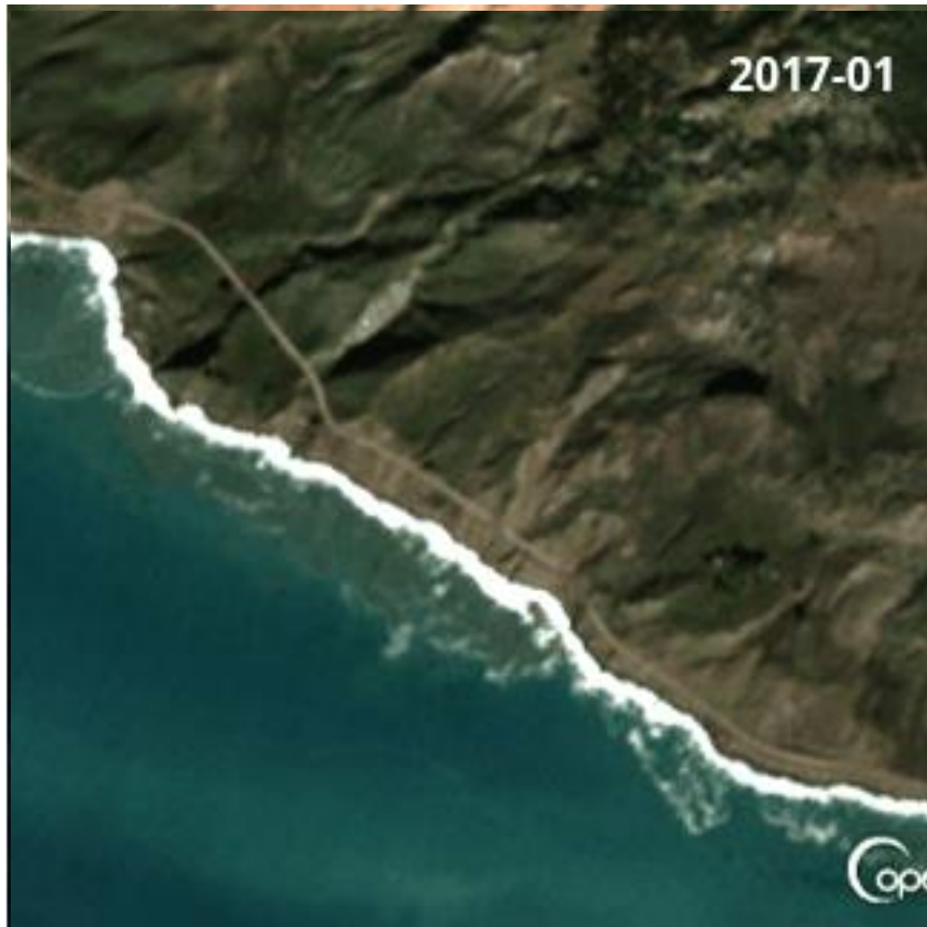
Deslizamiento lento y catastrófico
