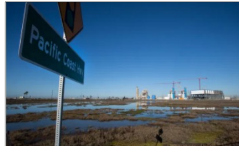
Planta generadora a gas AES Huntington Beach. Foto de Paul Bersebach, Fuente: Orange County Register/SCNG
